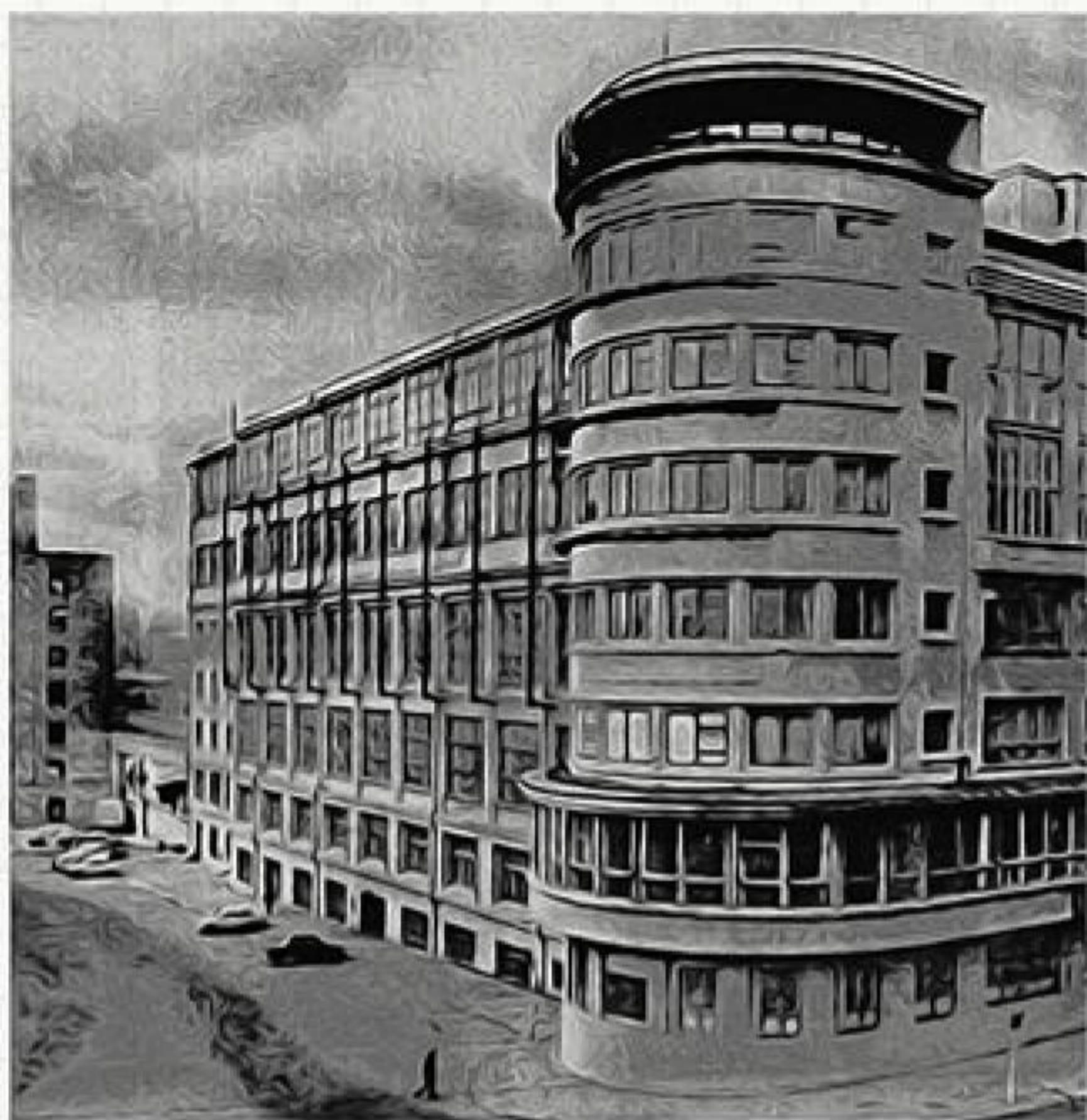
▲ Здание Центрального аэрогидродинамического института им. Н. Е. Жуковского. С весны 1939 по июль 1941 года здесь располагалась «Туполевская шарашка» - ЦКБ-29
